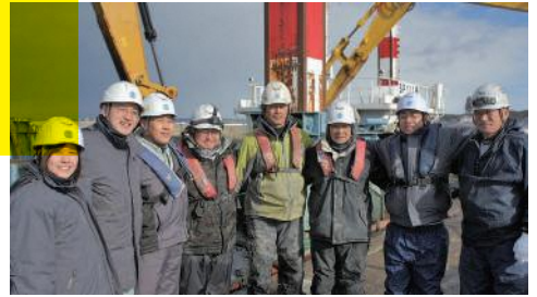
漁港工事の現場にて
